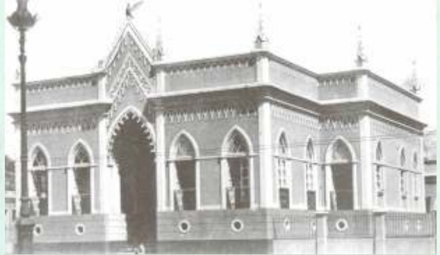
Prédio da Intendência Municipal, antiga sede da Prefeitura de Maceió.
