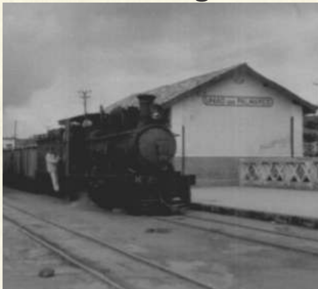
Estação ferroviária de União dos Palmares: pai de Povina Cavalcanti era funcionário da Great Western.
