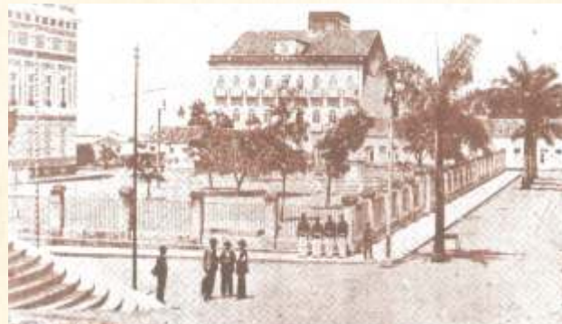
Praça Dom Pedro II, no início do século, refletindo os avanços arquitetônicos conseguidos desde que Maceió se tornara capital de Alagoas. O prédio que aparece à esquerda abriga a Assembleia Legislativa.
