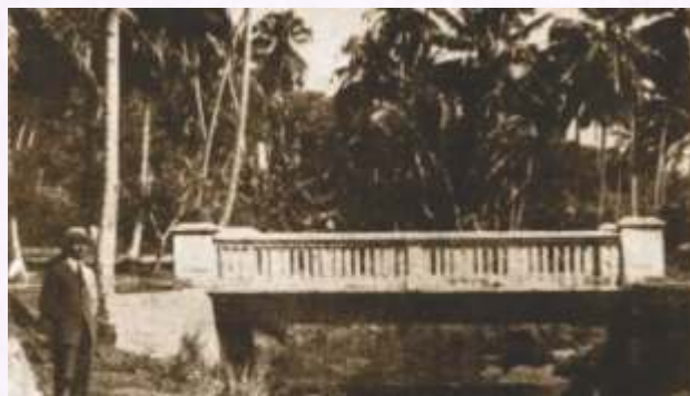
Ponte de Riacho Doce, em trecho da "Estrada do Norte": obra executada durante a administração de Fernandes Lima.
